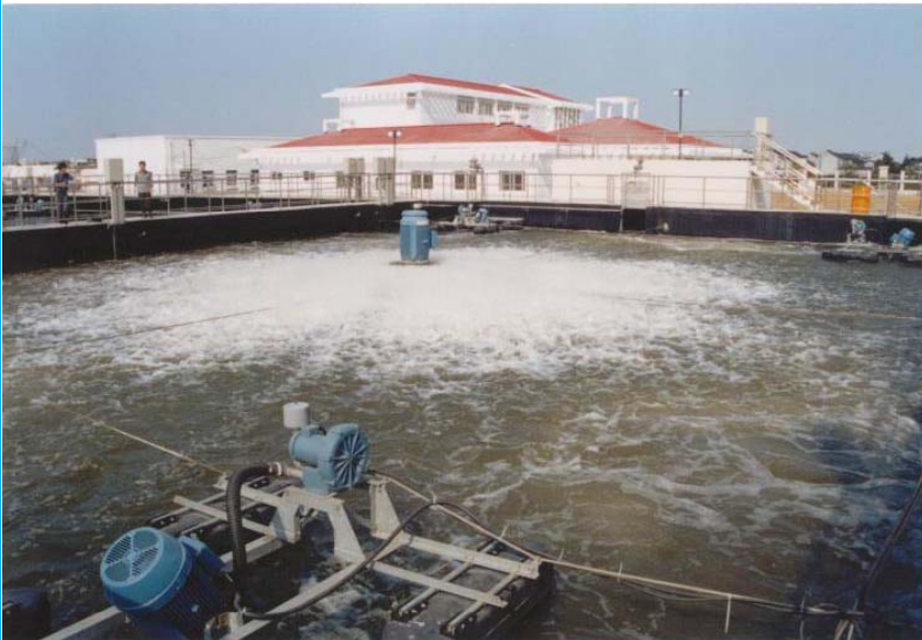
System ACT z 15kW Aire-O 2 ® Tritonami oraz aeratorami Aire-O 2 ® Turbo 125 kW
