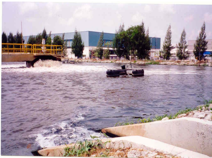
System ACT z 15kW Aspiratorem Aire-O 2 ® współpracujący z istniejącym aeratorem wolnobrotowym
