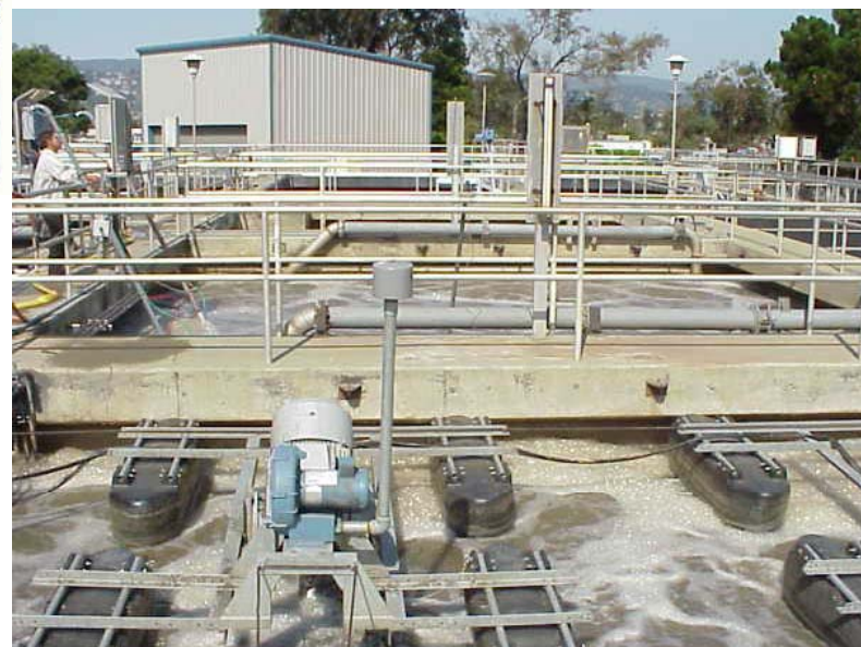
System ACT 18,5kW Aire-O 2 ® Triton or napowietrzanie wgłębne
